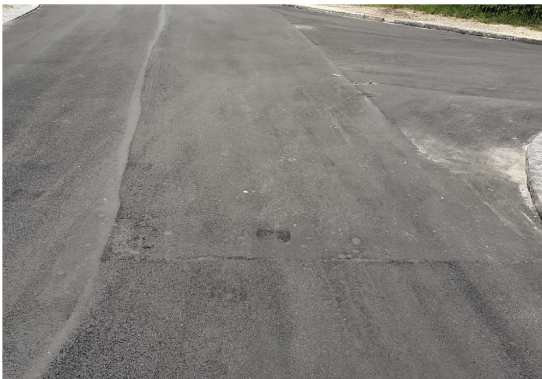
Foto 2.2.5: Eksempel på uens belægning og samlinger med "åbne" partier (Karl Gjellerup Allé mod Hannedal)
