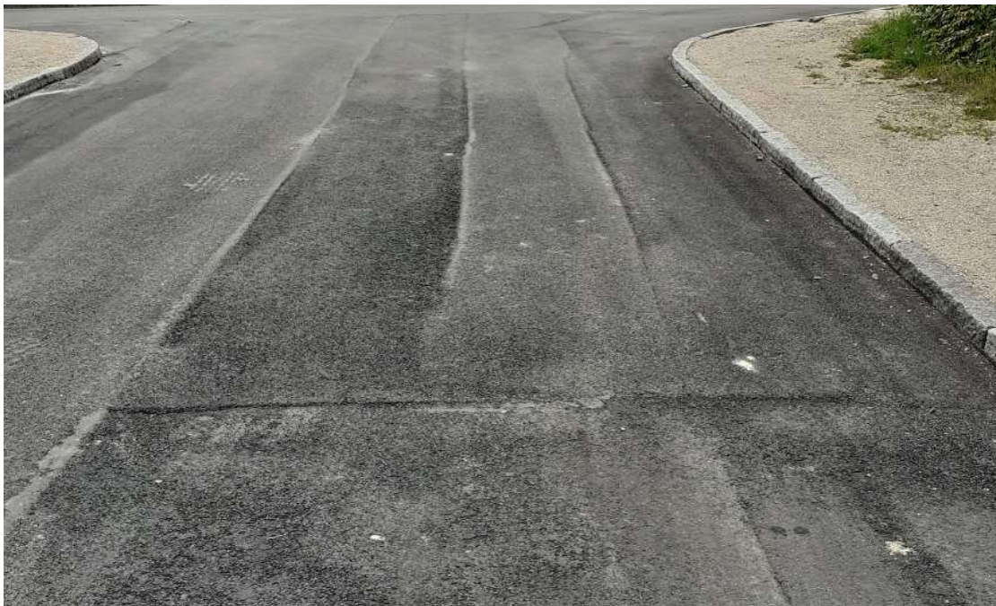
Foto 2.2.1: Eksempel på uensartet slidlag, med åben struktur (Hannedal)
