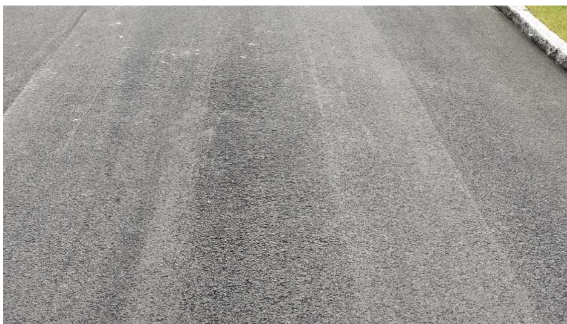
Foto 3.2.4: Eksempel på større "åben" plet
