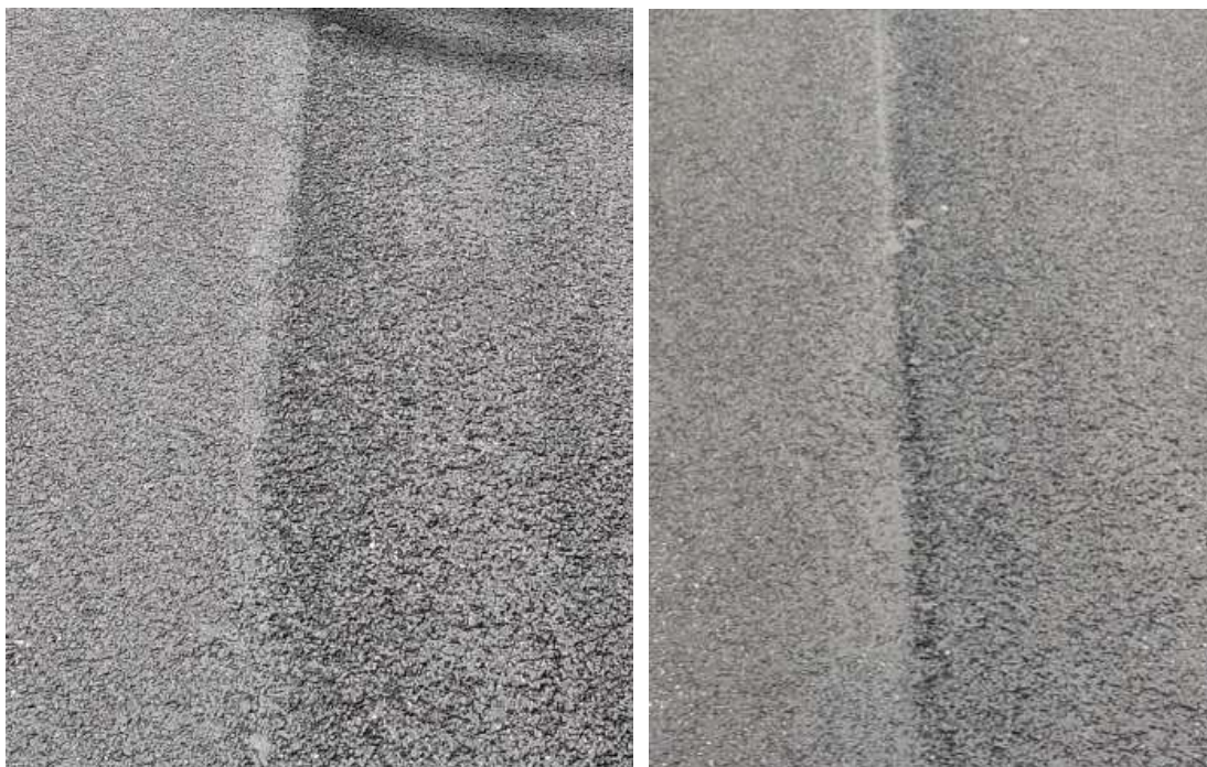
Foto 2.2.3: Eksempler på samling med åben struktur i 2. bane
