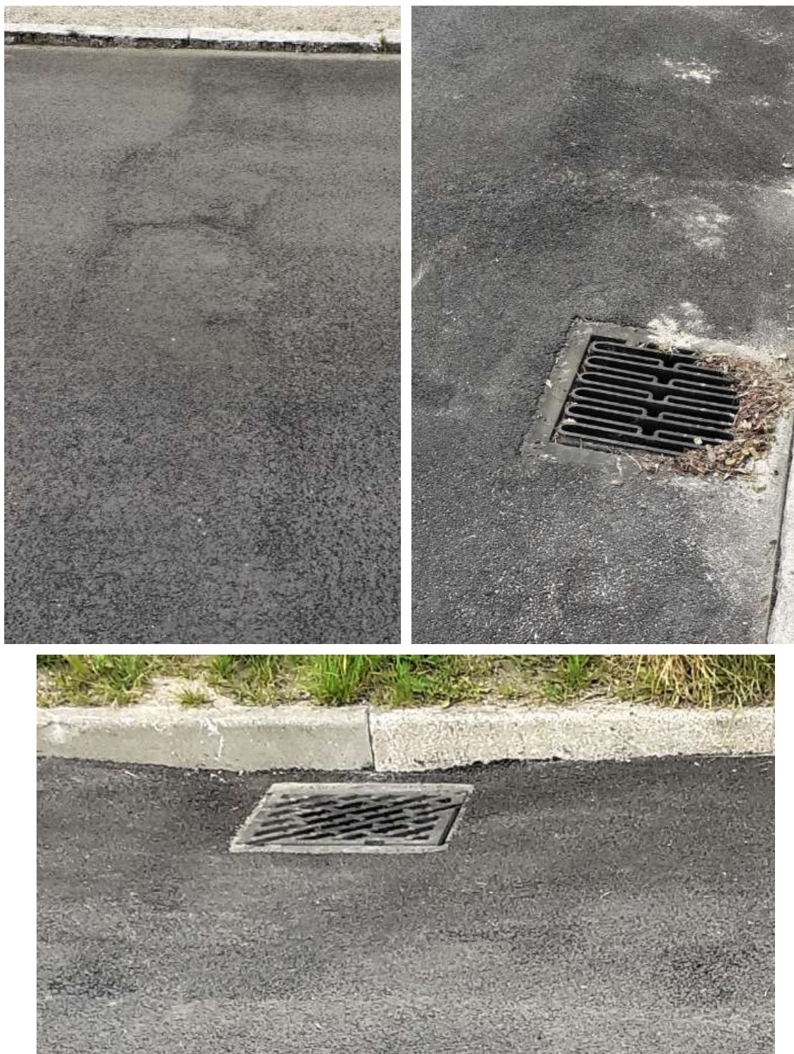
Foto 3.2.5: Eksempler på håndudlagt asfalt, med utilfredsstillende resultat.
