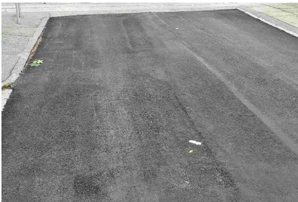
Foto 2.2.4: Eksempel på uensartet slidlag og samlinger, underkomprimeret (Hannedal)
