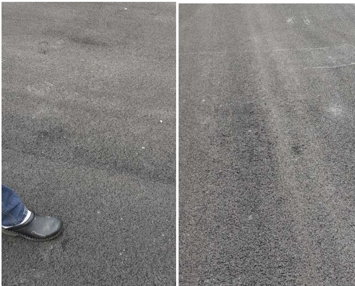
Foto 3.2.2: Eksempler på åbne pletter som nok skyldes "kolde klatter"
