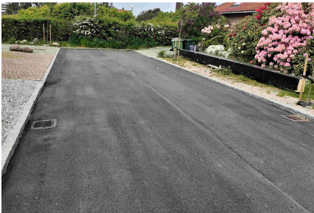
Foto 2.2.2: Eksempel på uensartet slidlag, med åben struktur (Marienborg Allé)
