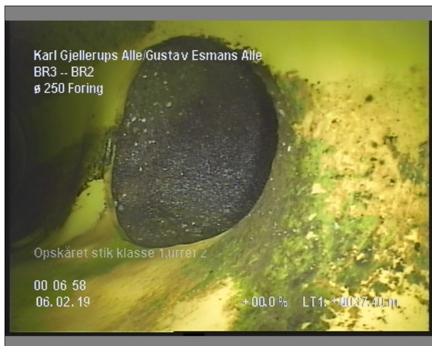
Foto: 4_11A, Medie #: LY19.9007, 00:06:59 37,4m, Opskåret stik klasse 1, urref 2
