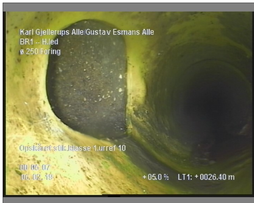
Foto: 1_13A, Medie #: LY19.9007, 00:05:07 26,4m, Opskåret stik klasse 1, urref 10
