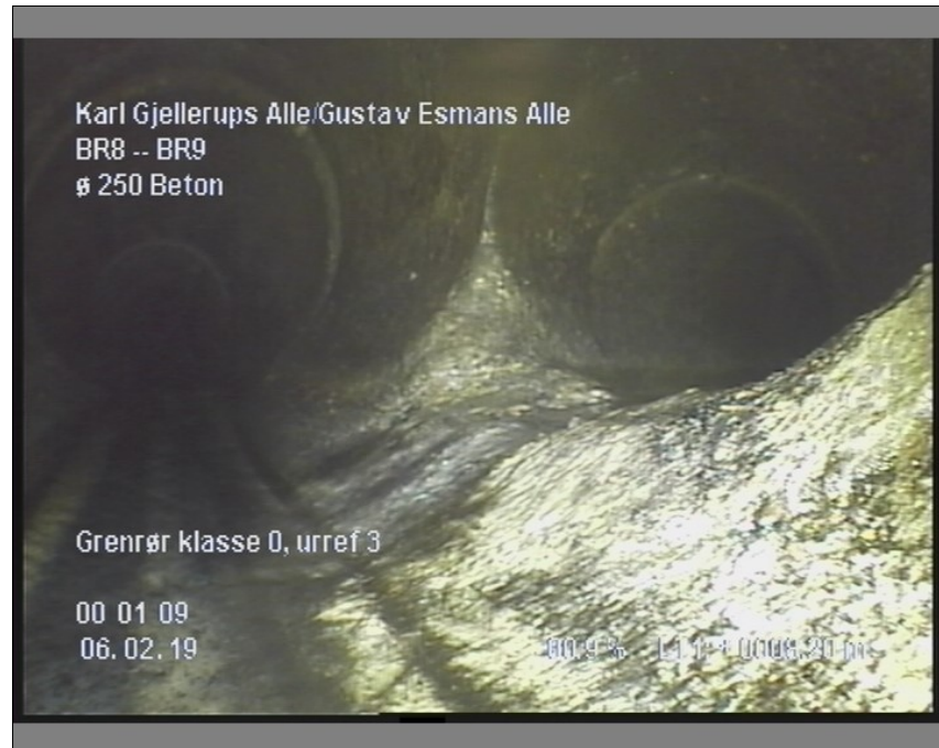
Foto: 11_5A, Medie #: LY19.9007, 00:01:09 8,2m, Grenrør klasse 0, urref 3
