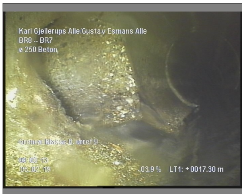
Foto: 8_14A, Medie #: LY19.9007, 00:03:14 17,3m, Grenrør klasse 0, urref 9
