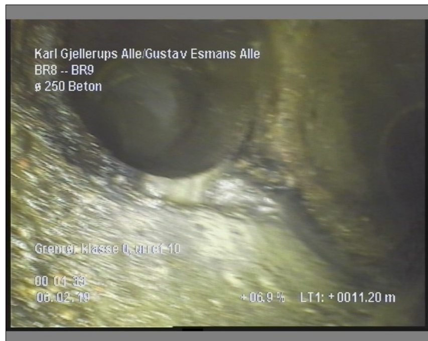
Foto: 11_7A, Medie #: LY19.9007, 00:01:34 11,2m, Grenrør klasse 0, urref 10
