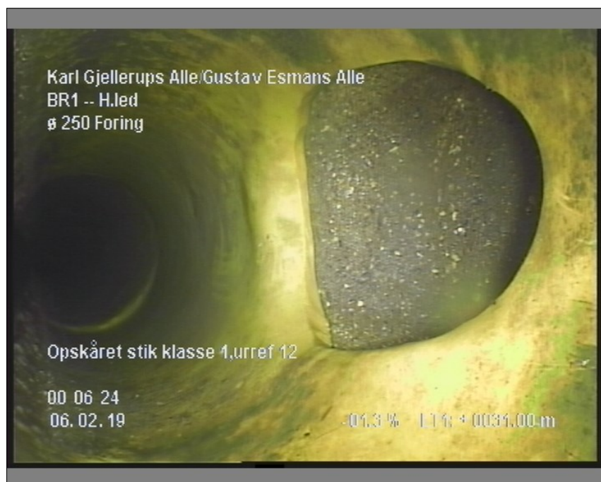
Foto: 1_17A, Medie #: LY19.9007, 00:06:24 31m, Opskåret stik klasse 1, urref 12
