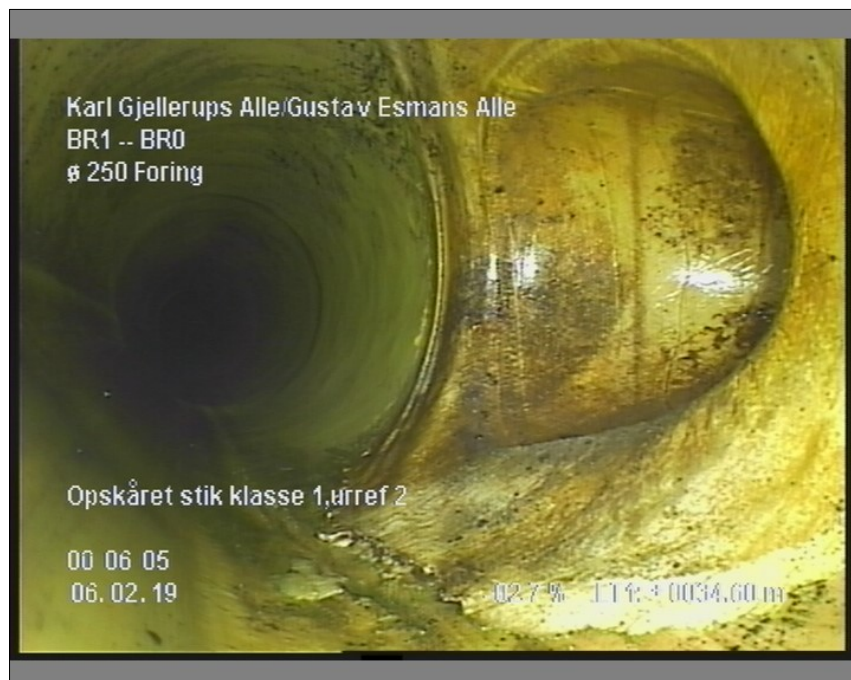
Foto: 3_18A, Medie #: LY19.9007, 00:06:05 34,6m, Opskåret stik klasse 1,urref 2
