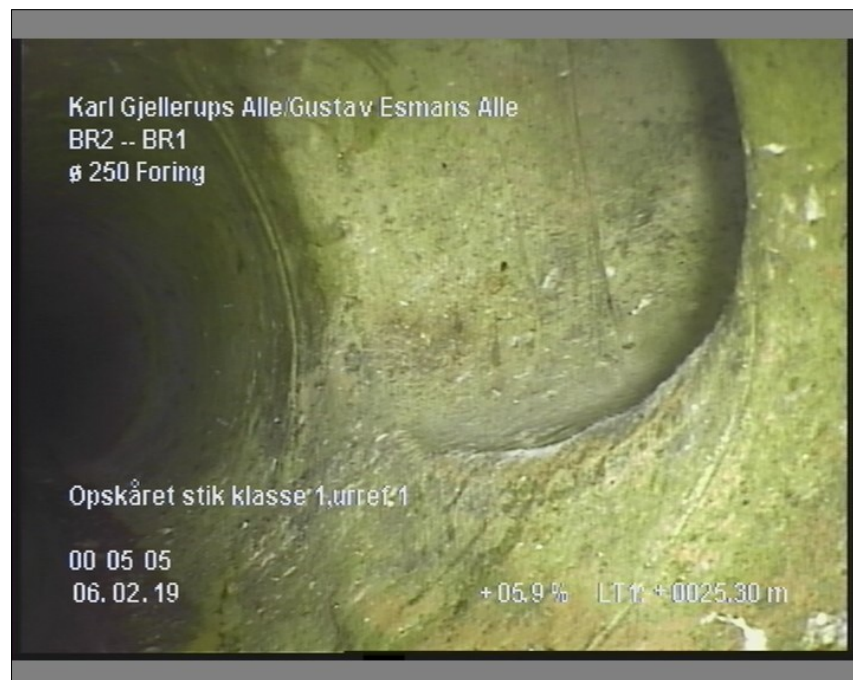
Foto: 2_19A, Medie #: LY19.9007, 00:05:05 25,3m, Opskåret stik klasse 1, urref 1
