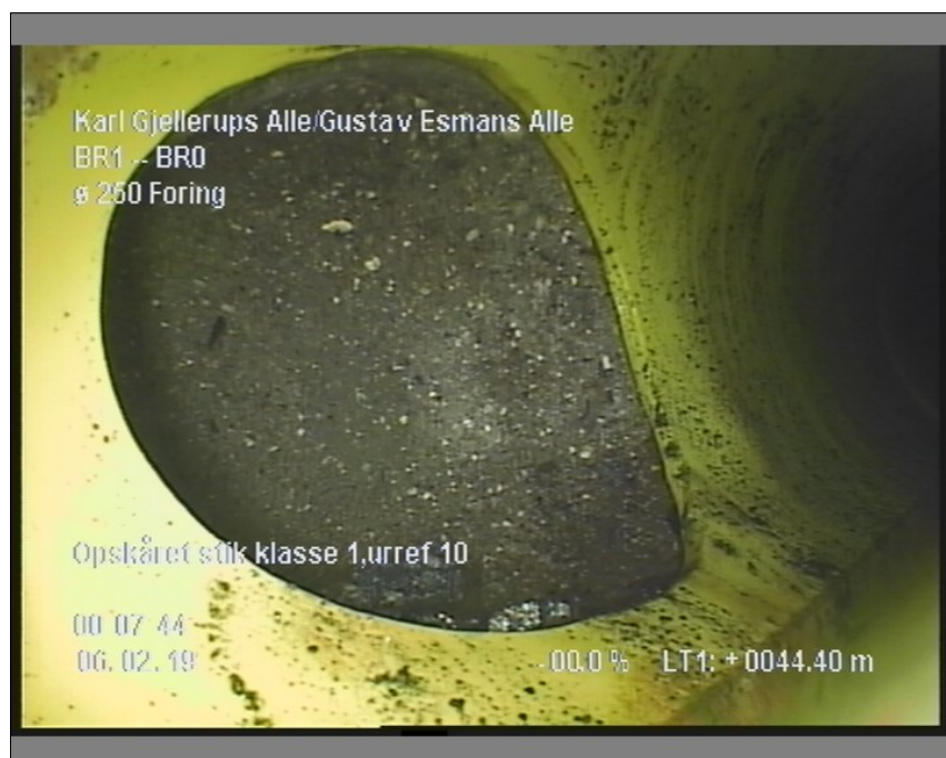
Foto: 3_22A, Medie #: LY19.9007, 00:07:45 44,4m, Opskåret stik klasse 1,urref 10
