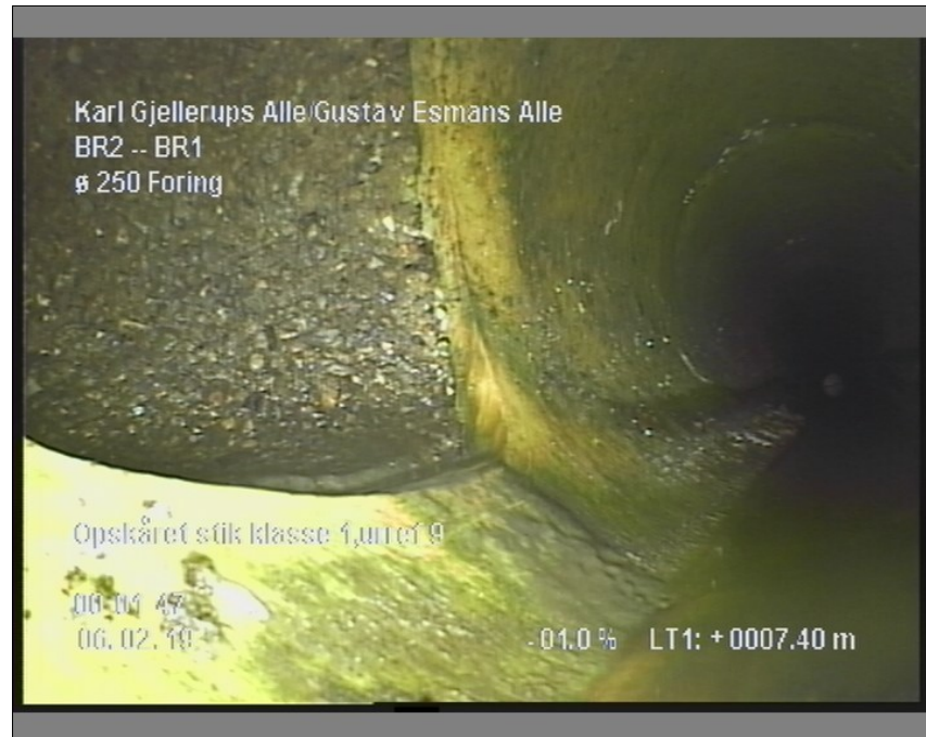
Foto: 2_9A, Medie #: LY19.9007, 00:01:48 7,4m, Opskåret stik klasse 1, urref 9
