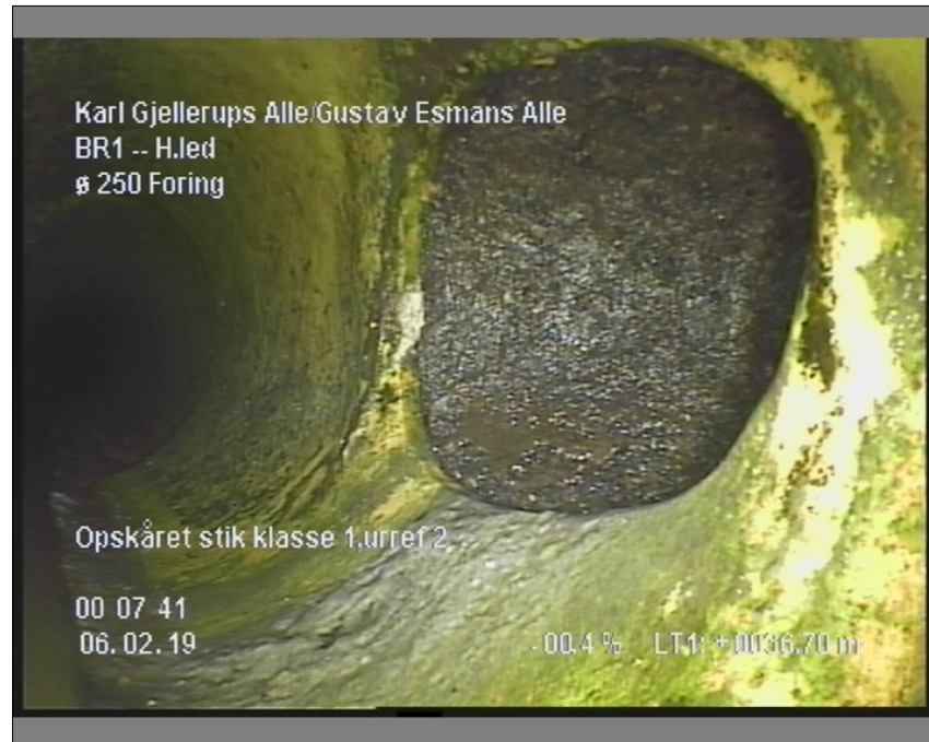
Foto: 1_20A, Medie #: LY19.9007, 00:07:42 36,7m, Opskåret stik klasse 1,urref 2
