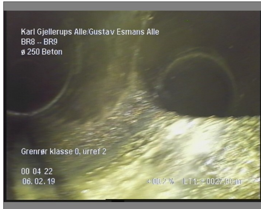
Foto: 11_12A, Medie #:: LY19.9007, 00:04:22 27,9m, Grenrør klasse 0, urref 2
