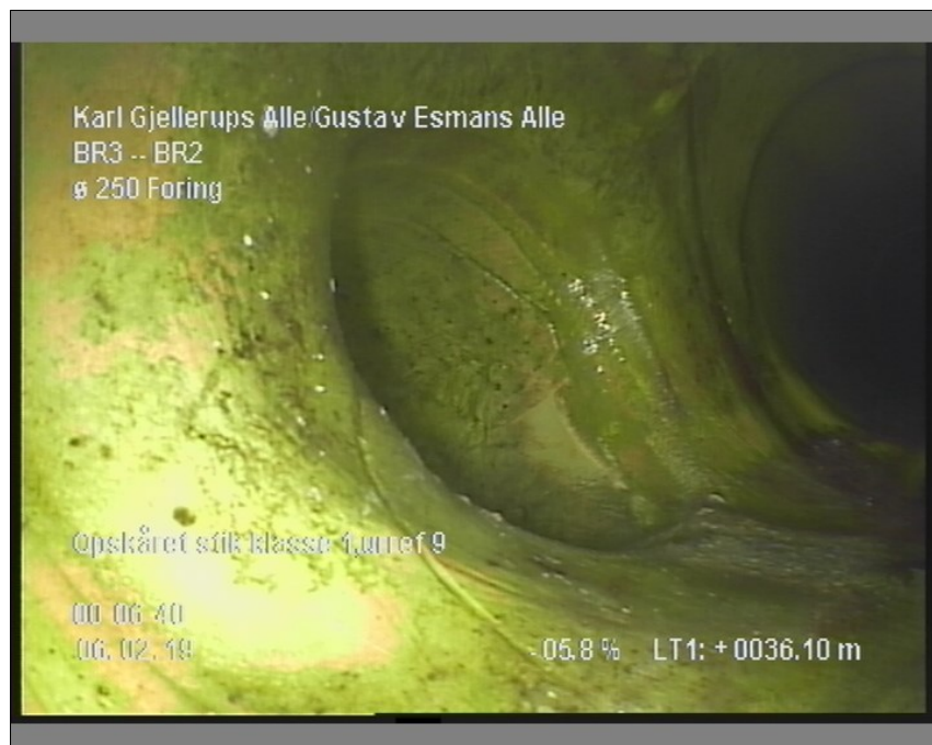
Foto: 4_10A, Medie #: LY19.9007, 00:06:40 36,1m, Opskåret stik klasse 1, urref 9
